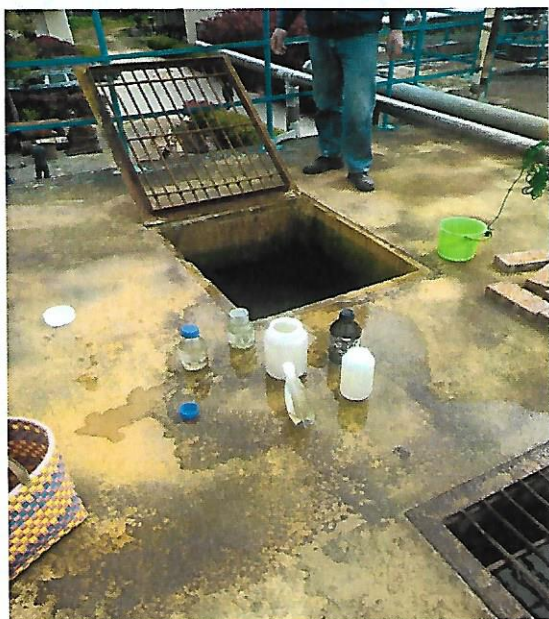
污水厂进水口
